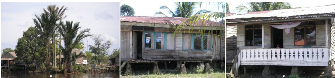
Gambar 8. Pemanfaatan pohon nibung ( Oncosperma tigillarium ) untuk penyangga rumah (a), sebagian penduduk sudah menggunakan penyangga rumah dari beton (b. dan c.) (Sumber: Tim Penelitian 2009)
