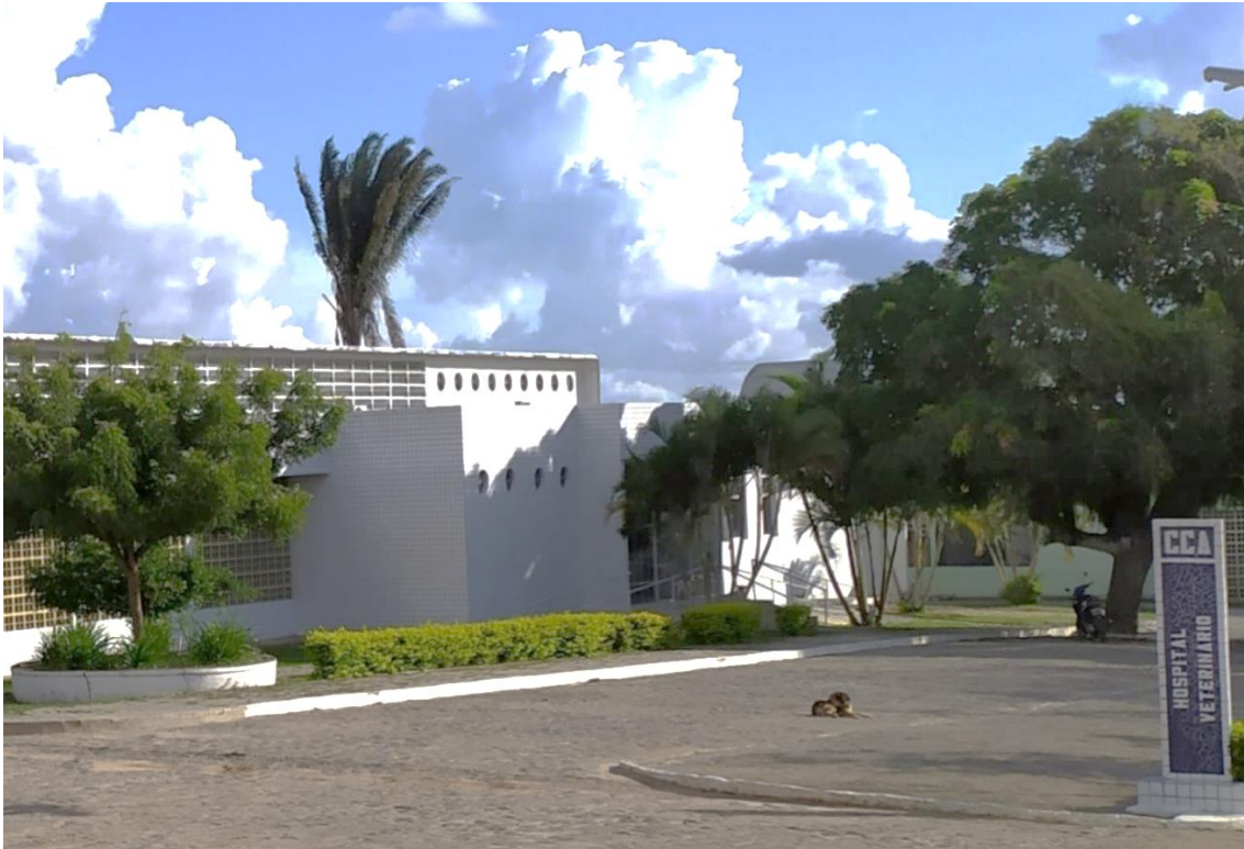
Figura 1: Fachada do Hospital Universitário Veterinário do CCC/UFPB.
