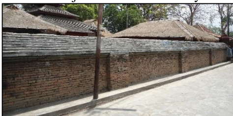
Gambar 4. Tembok keliling Kompleks Situs (Sumber: Mujabuddawat, 2013)
