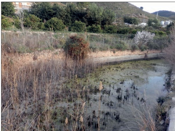
FIG. 8. Balsa de almacenamiento de las aguas del Caño de Inchola.
