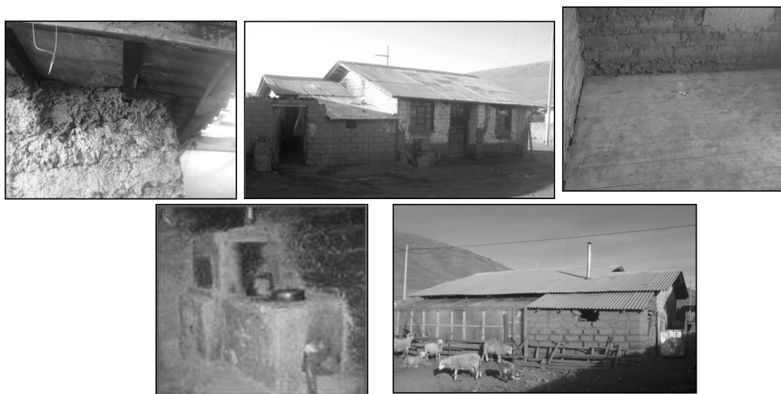
Figura 8. Imágenes de las modificaciones constructivas hechas en la vivienda. Arriba: sellado de las grietas para evitar infiltraciones de aire, techo aislado con claraboyas e invernadero adosado, piso aislado. Abajo: cocina mejorada e invernadero adosado a dormitorios.
