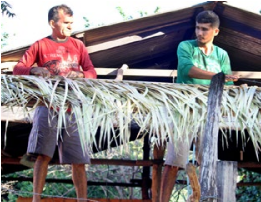
Seu Guilherme e Silvaldo trabalhando juntos na cobertura de um galpão.
