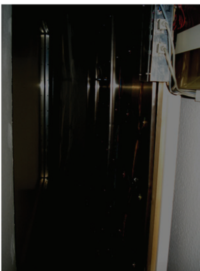
Photo 1: Blick hinter die Leinwand auf die LED-Leuchten.
