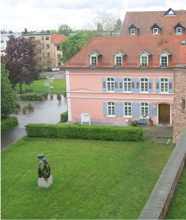
Abb 4: Standort des Lichtspielhauses Ladenburg, heutige Situation, aufgenommen aus dem ehemaligen Schloss das heute das Lobdengau-Museum beherbergt. In einer Baracke hinter dem Gasthaus „Schiff“ befand sich ab 1920 das Lichtspielhaus Ladenburg. Sie wurde nach 1968 abgerissen. Heute befindet sich dort eine Wiese. Wo früher der Anbau an das Gasthaus anschloss, fehlen die Fenster.
