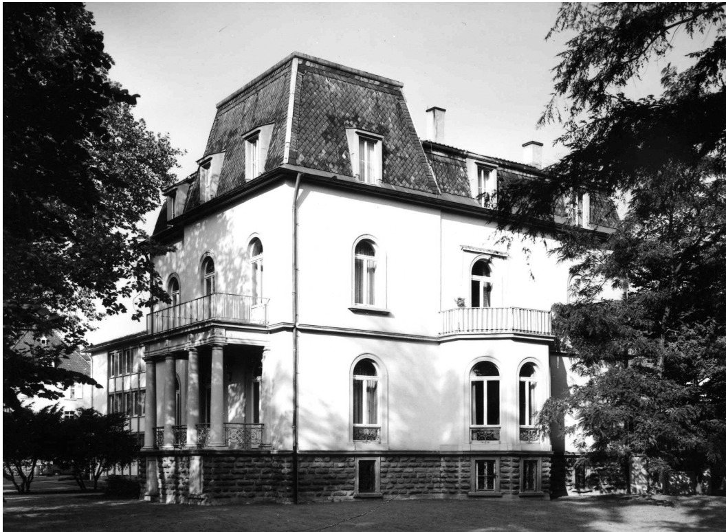
Fig. 18. Die Villa (heute meist als „Altbau“ oder „Bibliotheksbau“ bezeichnet) auf dem Grundstück Mönchhofstraße 12-14 in Heidelberg-Neuenheim. Blick von Südosten. Im Hintergrund ist links der Neubau zu sehen. Quelle: Photo im Archiv des Astronomischen Rechen-Instituts, aufgenommen ca. 1960/61.
