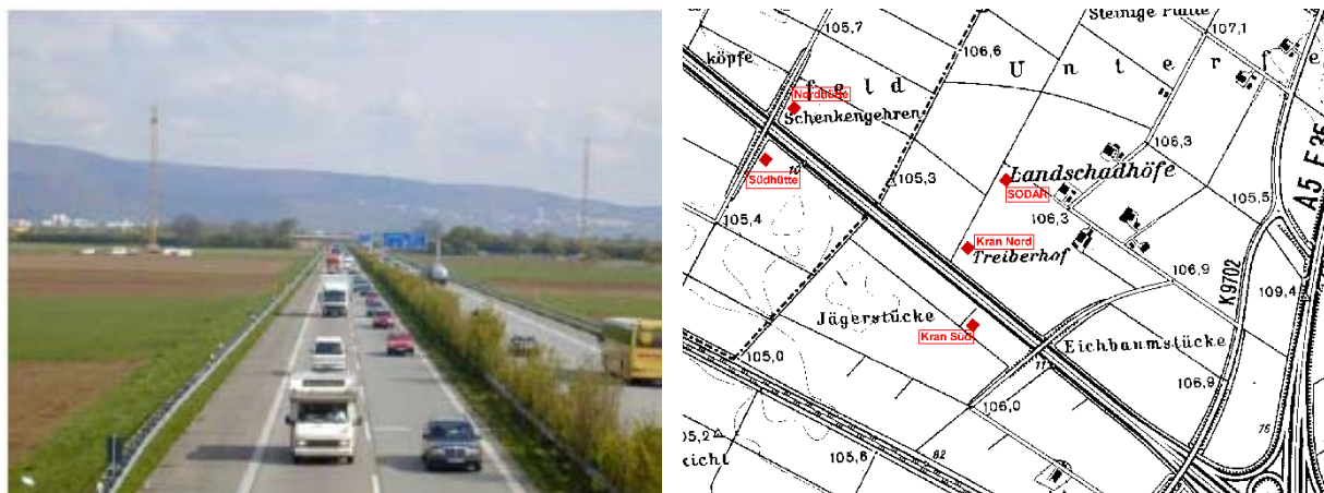
Abbildung 5.8: Kran-/ Messtürme an der A 656.
