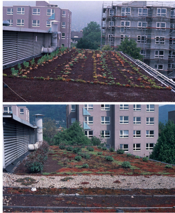
Pflegeloses Pflanzendach im ersten Jahr (oben) und vier Jahre später (Foto: P. Schneider).
