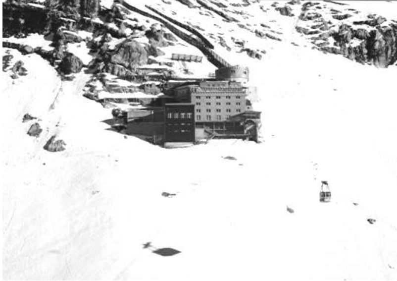
Abbildung 8.1: Umwelt-Forschungsstation Schneefernerhaus (2650 m) im Südhang des Zugspitzgipfelbereichs, etwa 310 m unterhalb des Gipfels gelegen. Der Einlass des Instruments wurde durch ein Fenster im 5.OG am rechten Rand und oberhalb der zweiten Experimentierterasse installiert.
