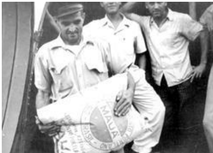
Figura 4: Primeiro saco de cimento produzido pela CNCMP (Jürgens 2007)
