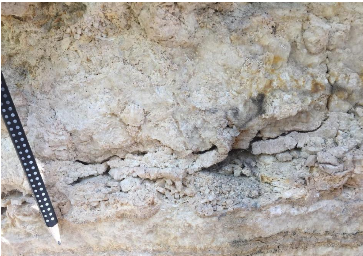
Figura 18: Brecha Intraformacional localizada no ponto M01
