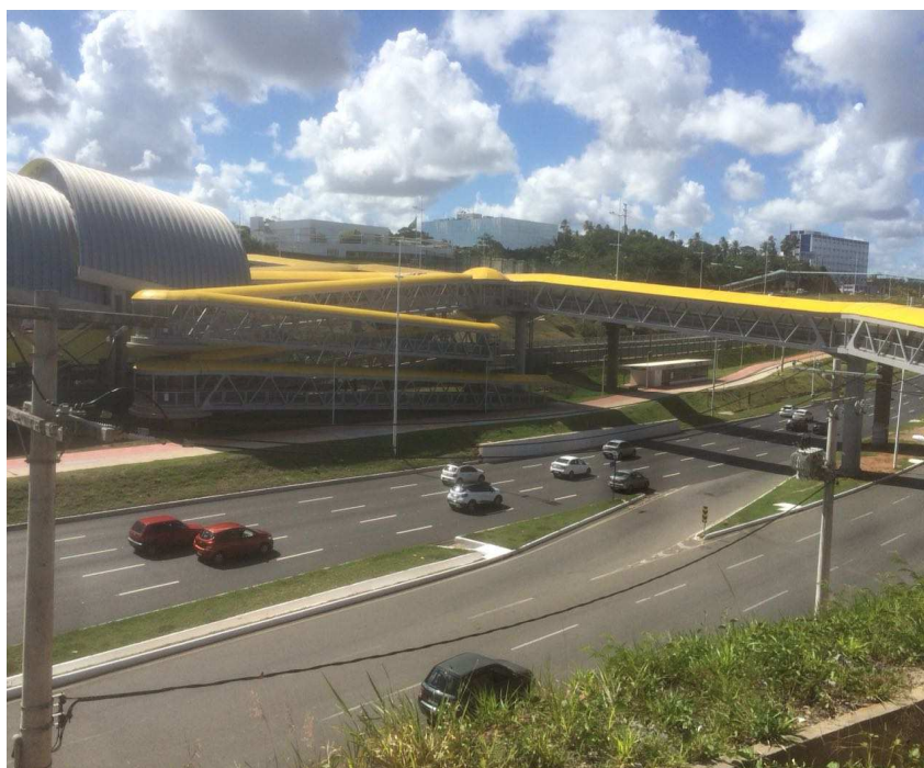
Figura 25: Passarelas implantadas na Av. Luís Viana Filho, próximas à estação de metrô do Imbui – Salvador, Bahia.
