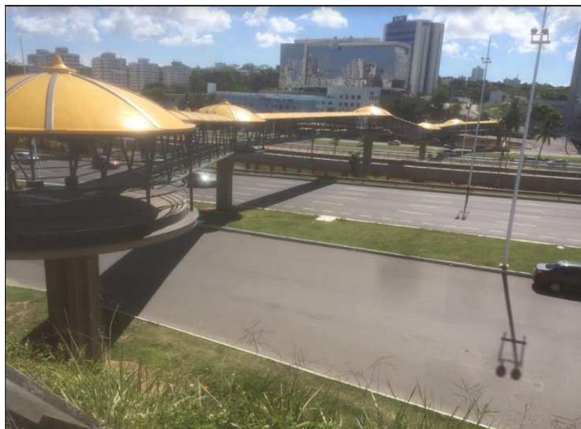
Figura 24: Passarelas implantadas na Av. Luís Viana Filho, próximas à estação de metrô do Imbui – Salvador, Bahia.
