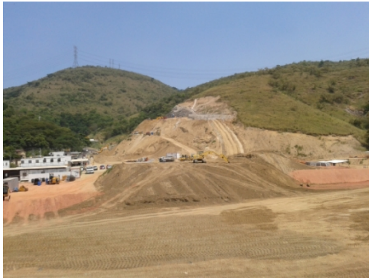
Figura 7 – Obras de terraplenagem na praça de pedágio e contenção em cortina atirantada ao fundo (Autor)
