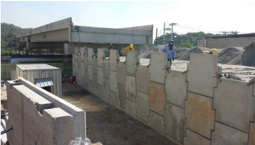
Figura 9 - Elevação de muro com escamas pré-moldadas de concreto e aterro reforçado com fitas metálicas
