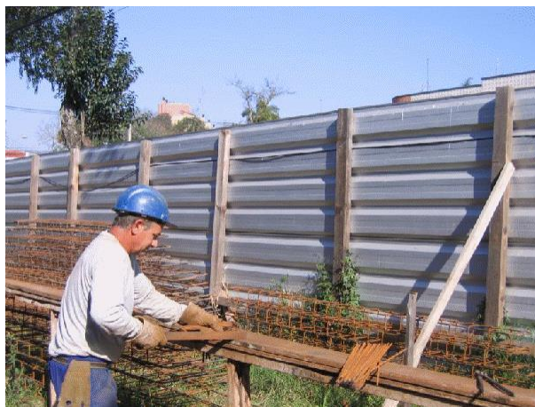
Figura 3 - Corte e dobra de aço manual
