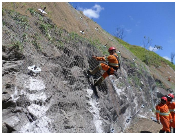
Figura 20 - Conferência de torque
