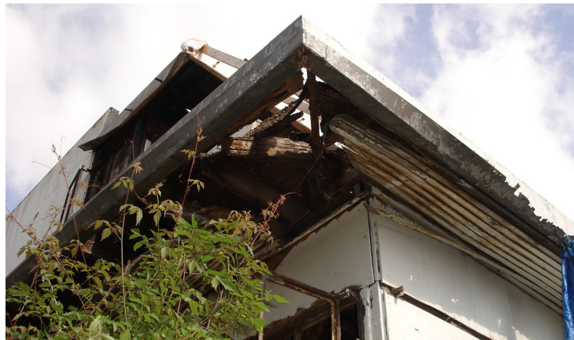
Soffit ventilation (before)
