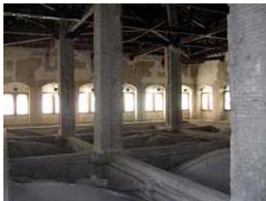
Aspecto actual del interior de la planta superior de la Lonja
