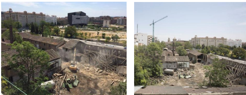
Imágenes del derribo
