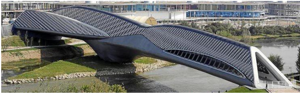
Vista exterior del Pabellón Puente
