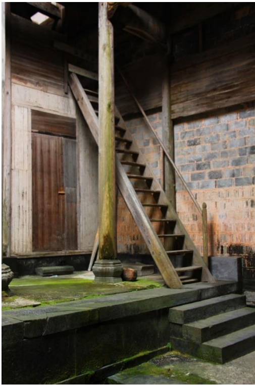
Foto 7 Escaleras de madera
