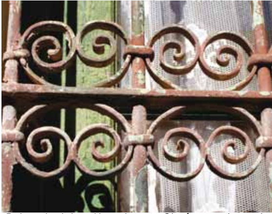
Reja colonial en Humahuaca. Obsérvese el uso de remaches en lugar de soldaduras.
