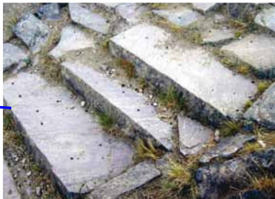
Grandes lajas ubicadas como escalones en el Camino entre Santa Ana y Valle Colorado.
