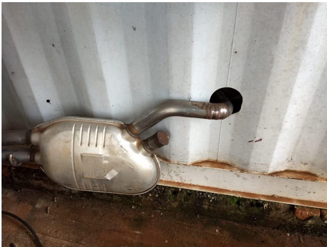
Figura 20 - Nova saída do escapamento já com a posição paralela ao contêiner
