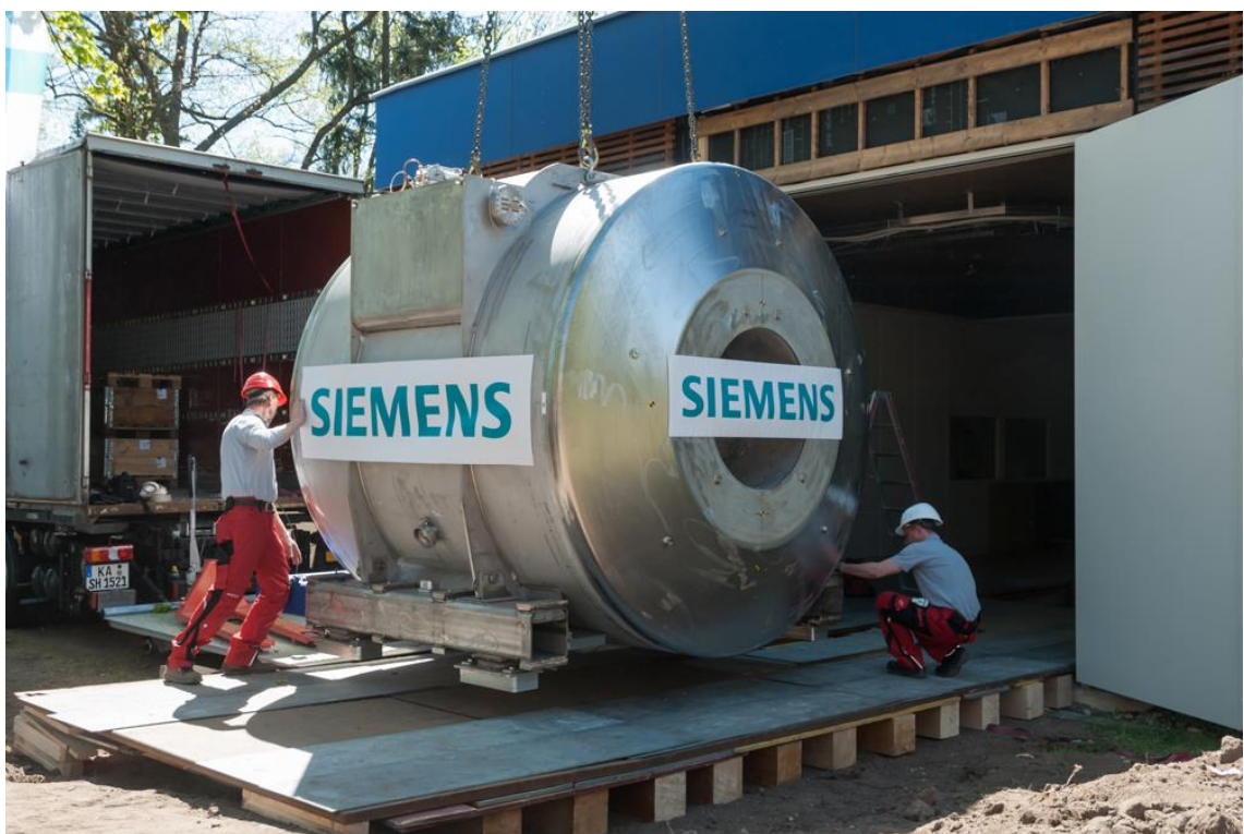
Figura 25 - Transporte de um magneto modelo OR98, utilizado no sistema de ressonância magnética Siemens Magnetom Aera, capaz de gerar um campo magnético de 1,5 Teslas [53].
