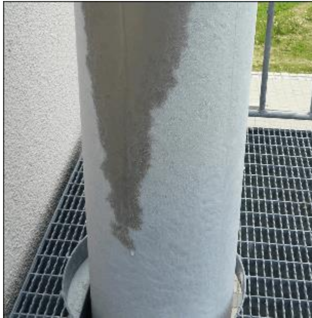
Figura 30 - Tubo quench em sua parte externa, sem isolamento no tubo. É possível se observar uma condensação (rastros mais claros da imagem), por conta da baixa temperatura interna no tubo.
