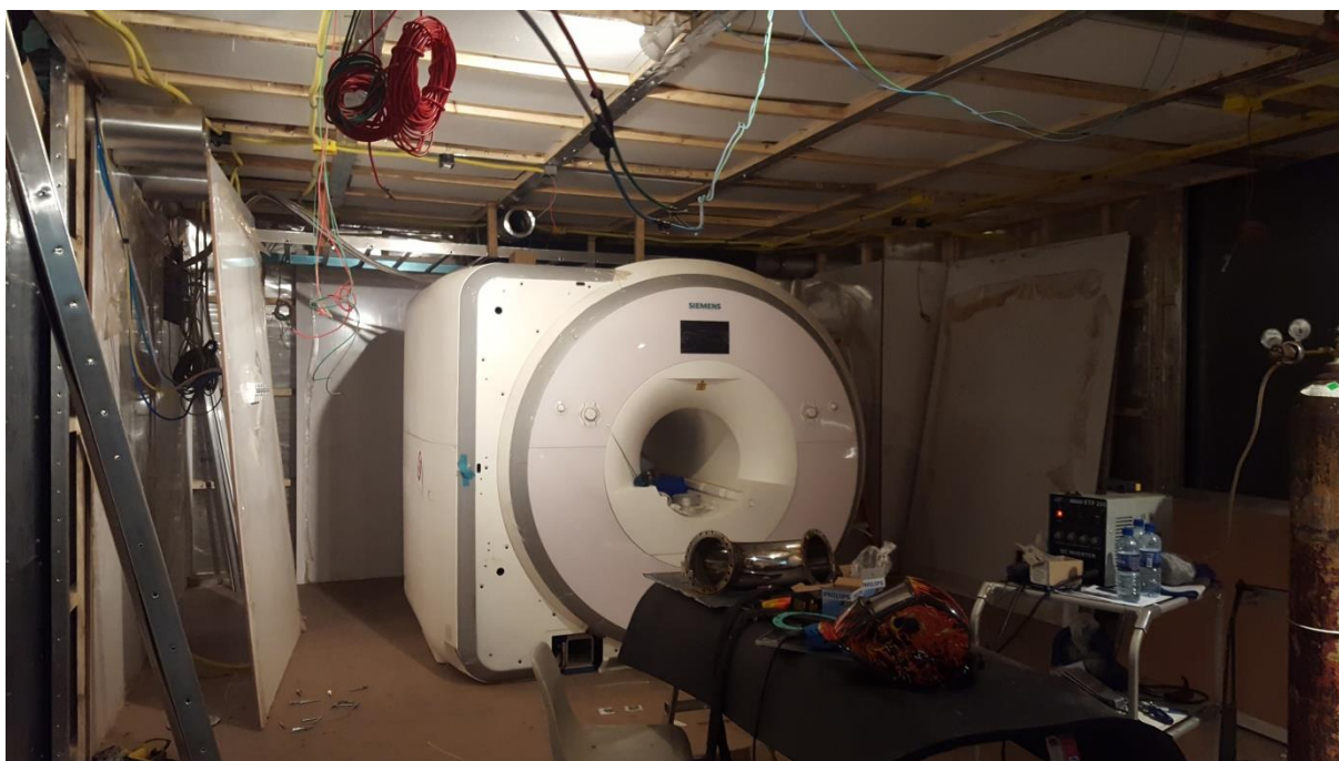
Figura 37 - Sala de exames de um sistema de ressonância magnética, em etapa de finalização da gaiola de Faraday. É possível observar-se a estrutura de madeira e alumínio no teto e paredes. Imagem de acervo pessoal
