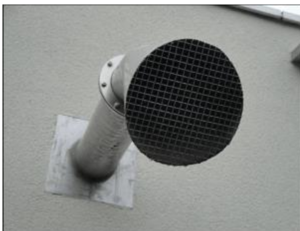
Figura 34 - Exemplo de saída do tubo com malha de arame quadrada de aço inoxidável, com área da malha maior que 2,5 vezes o tamanho do tubo quench e malha com 10 + 2 / -1 mm [56].
