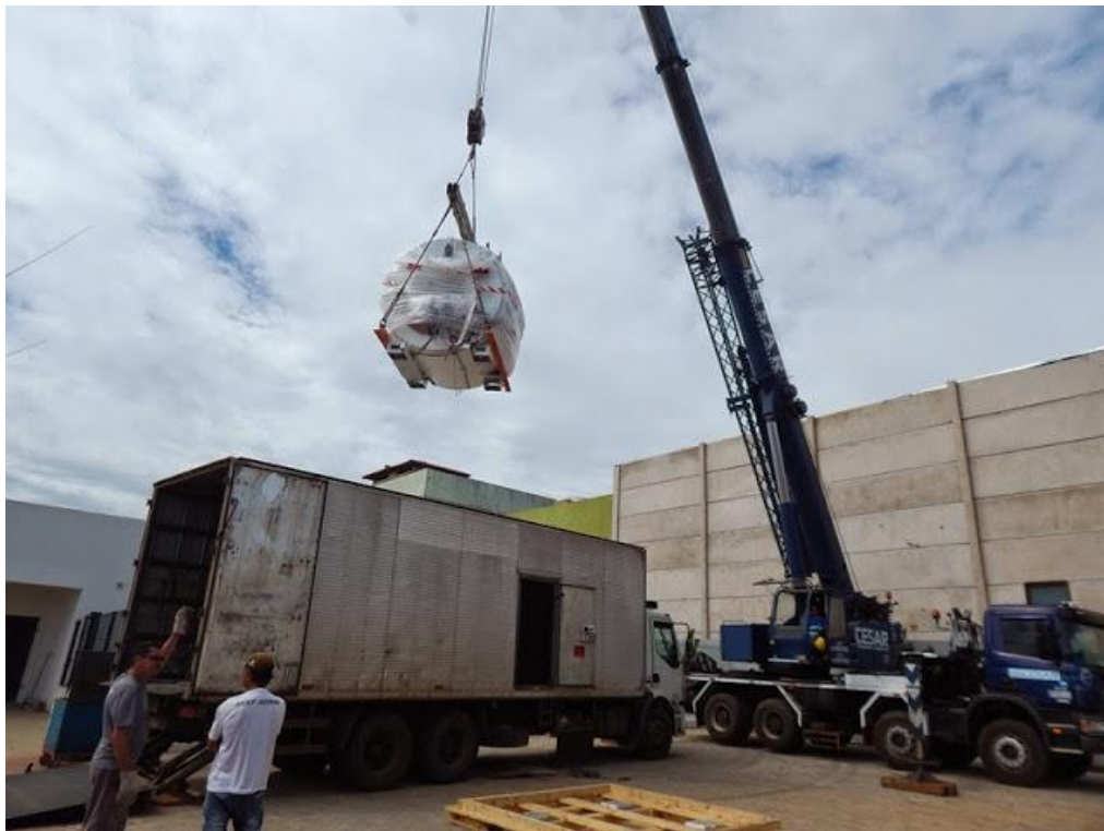
Figura 27 – Transporte de um sistema de ressonância magnética para seu site durante instalação. Seu acesso à sala de exames é comumente feito por um guindaste com acesso pelo teto [54].
