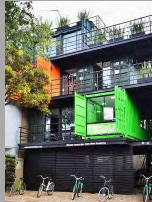
Edifici habitatge de Keetwonen Tempohousing, NL (2005-2006)
