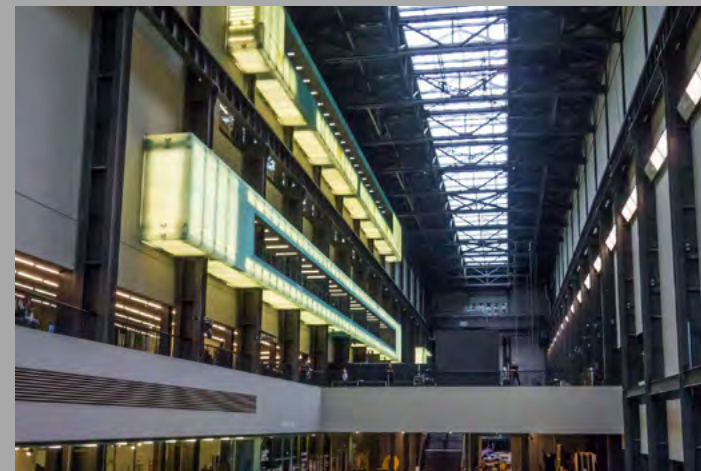
Tate Modern, antiga fàbrica de turbines. Londres, UK (1996-2000)
