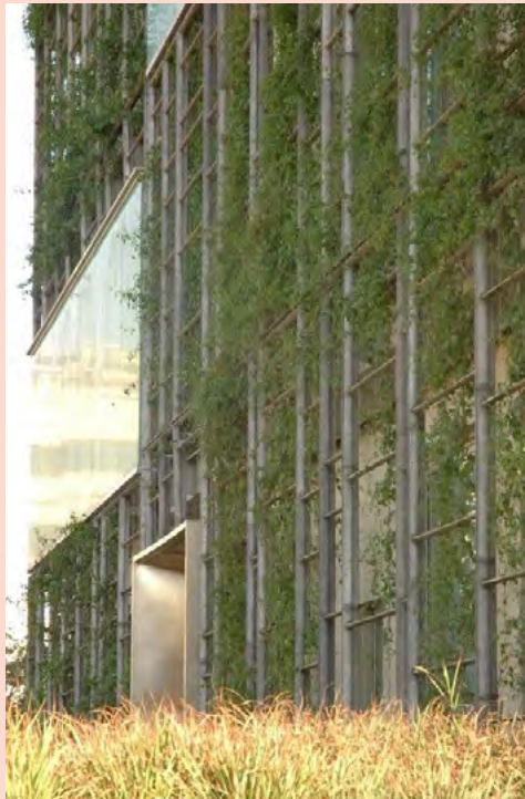
Edifici KMC a Hyderabad, Índia (2012)
