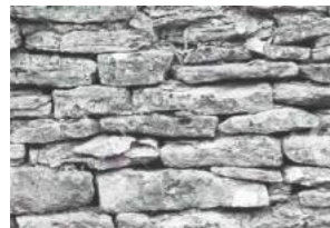
Mur de pedres llicorella sense treballar.
