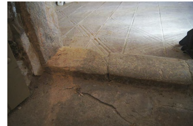
1. Canvi de paviment i paret de pedra
