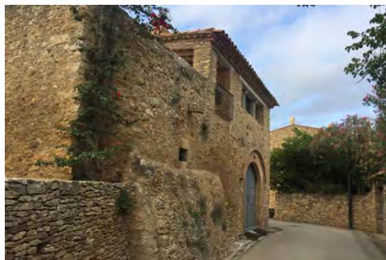
Fig.9. Vista del desnivell del Carrer de la Font.
