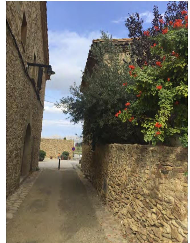
2 Vista exterior lateral de la masia
