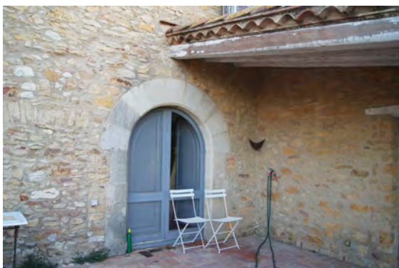
Fig.11. Vista de la terrassa descoberta del primer pis.
