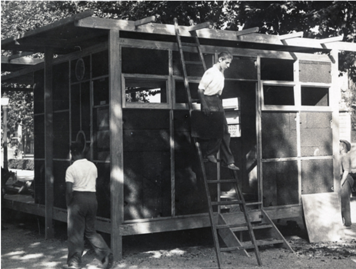
1932. Montaje de la caseta desmontable en la Plaza Berenguer de Barcelona
