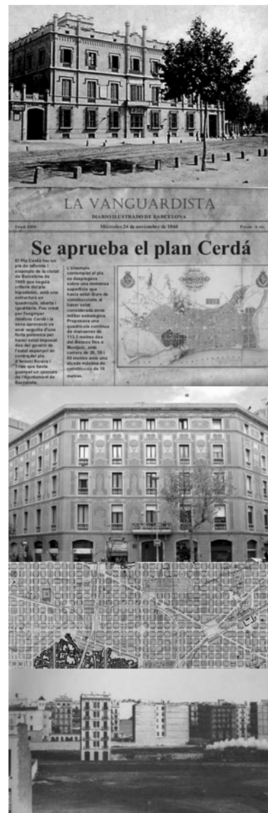
De dalt a baix: la casa Gibert, 1861; la portada de la Vanguardia del 24 de novembre de 1860 on s'anuncia l'aprovació del Pla Cerdà; la façana de l'edifici de de xamfrà a Roger de Llúria amb Passeig de Gràcia; plànol amb la trama proposada per Cerdà; construcció de la dreta de l'eixample.
