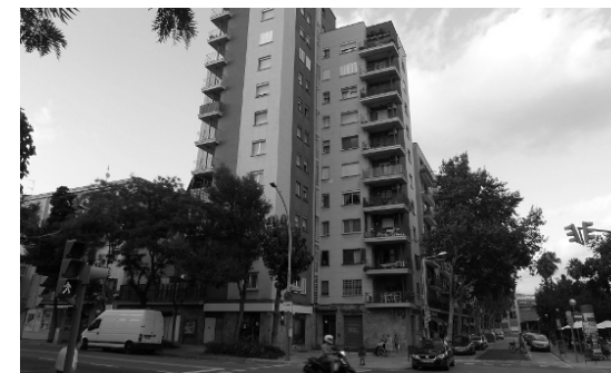
De dalt a baix: vista panoràmica del barri de Congrés en construcció, 1952; primeres edificacions del barri (esquerra); Can Ros i els seus terrenys on es va construir el barri al fons (dreta); bloc de cases a la cantonada del carrer Felip II amb la Plaça del Congrés Eucarístic on hi ha la primera pedra de la construcció del barri
