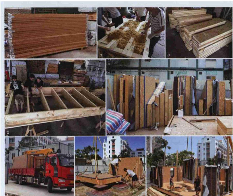
a 稻草板, b 组合龙骨内填充木屑, c 组合龙骨, d 墙体模块组装, e 组装完成的墙体模块
