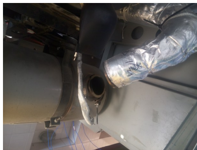
图 14 消声器和排气管脱离
