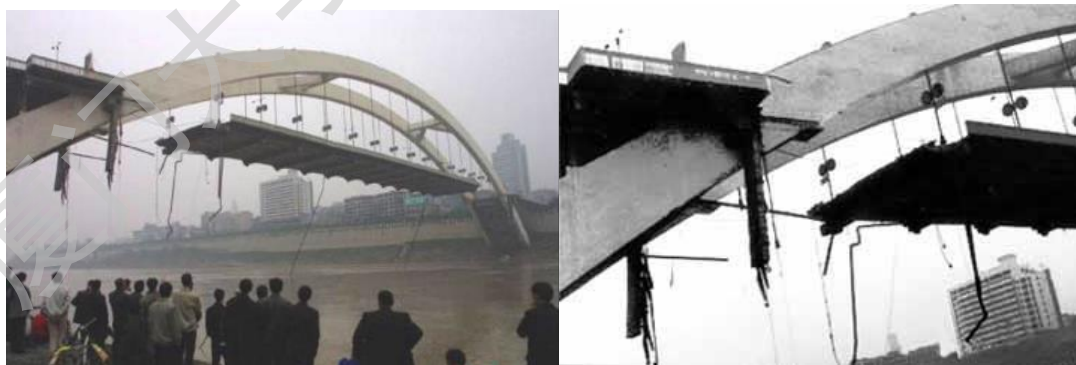
图 1-1 宜宾南门大桥垮塌
