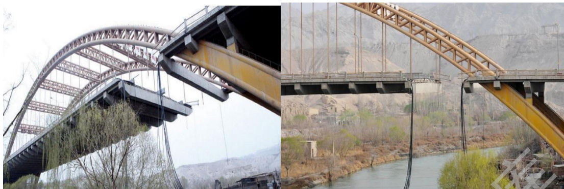
图 1-2 孔雀河大桥垮塌
