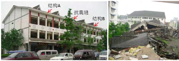
(a) 地震前结构 A 与 B (b) 地震后结构 B 倒塌
