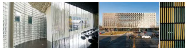
图1 通过改变透明材料和不透明材料构成方式形成半透明表皮
