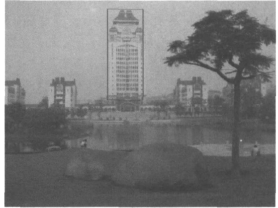
Fig. 9 Detection result for the original image in Fig. 1. 图 9 对图 1 的原图像进行建筑物检测的结果
