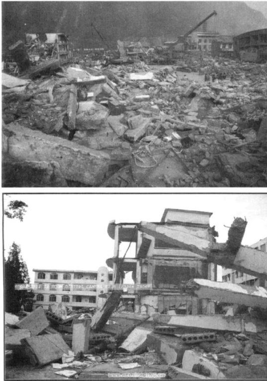
图2 汶川震后倒塌现场
