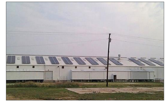
Solar Pv - non utility scale
