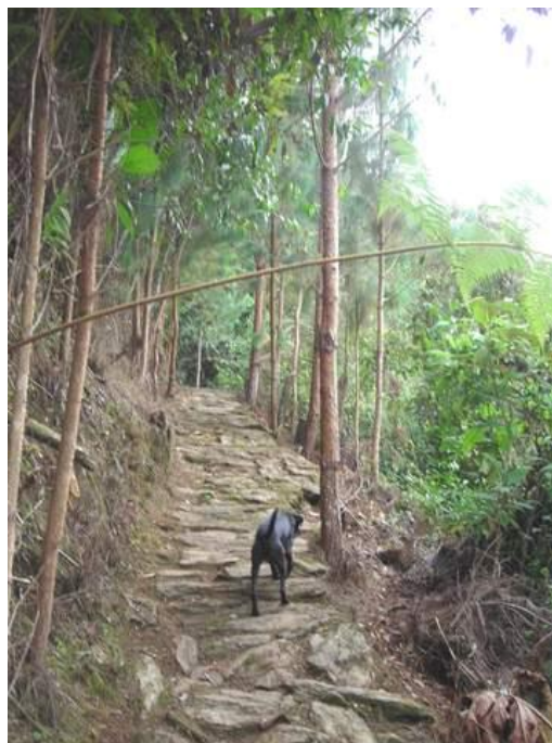
Fotografía 102. Fotografía de 1992 que muestra lo que probablemente podría ser uno de los tramos del camino de La Cristalina con sus rasgos constructivos originales antes de ser intervenido para su reconstrucción.
