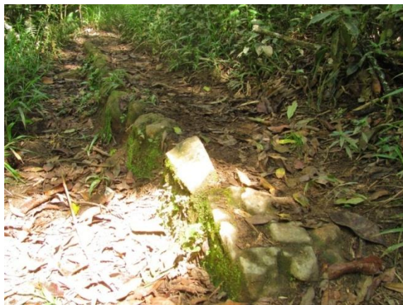
Fotografía 90. Detalle constructivo del refuerzo lateral del camino en piedra en uno de sus tramos aun conservados
