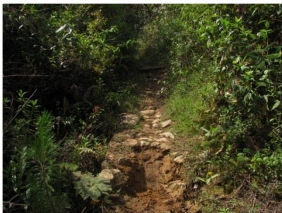
Fotografía 93. Detalle del grado de erosión y deterioro que presenta actualmente el camino en uno de sus tramos donde la bancada era en piedra. Nótese la profundidad de la erosión producto de la huella ergonómica humana y animal
