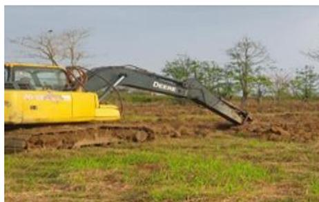
Figura 36. Subsuelado con retroexcavadora
