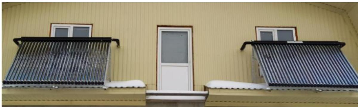
Рисунок 1 - Вакуумные трубчатые солнечные коллекторы на 30 трубок
