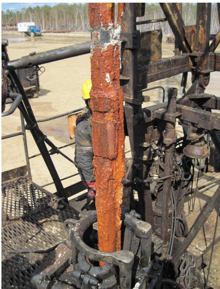
Рисунок 7 – Коррозионное воздействие сероводорода
