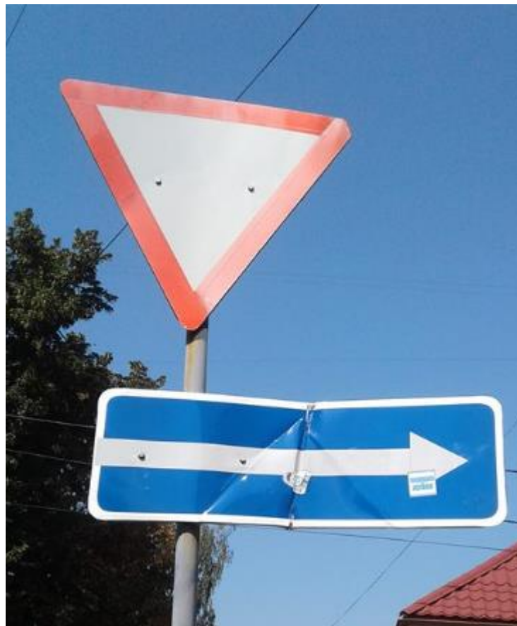
Рисунок 1.2. Приклад деформованого дорожнього знаку
