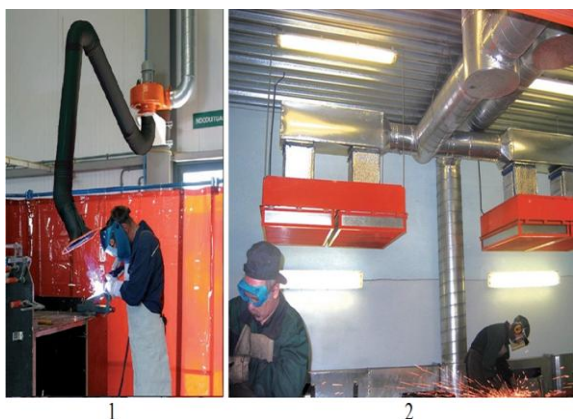
Рисунок 1 – Промислова вентиляція: 1 – місцева; 2 – загально обмінна
