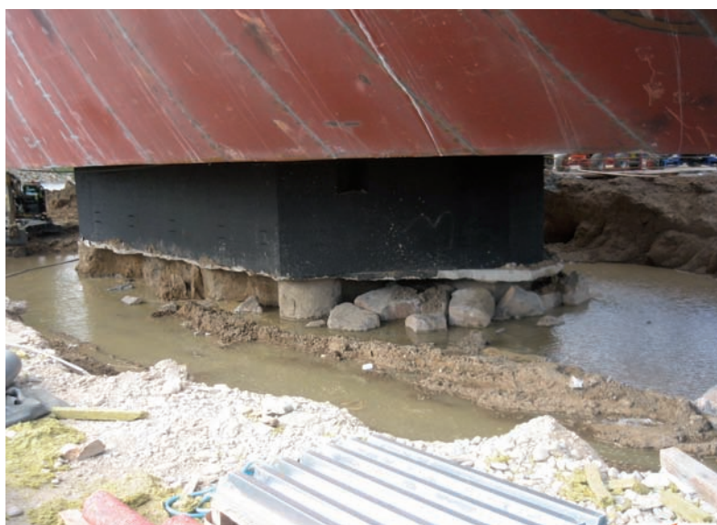
Fig.15. Encepado (color negro) y tablero (rojo) dentro de la excavación tras la colocación de la primera escollera, antes de soldar el cáliz.
