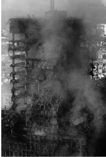
Figura 1-3. Imagen del derrumbe de los pórticos apantallados del ala norte en el incendio del Edificio Windsor de Madrid el 12/02/2005.
