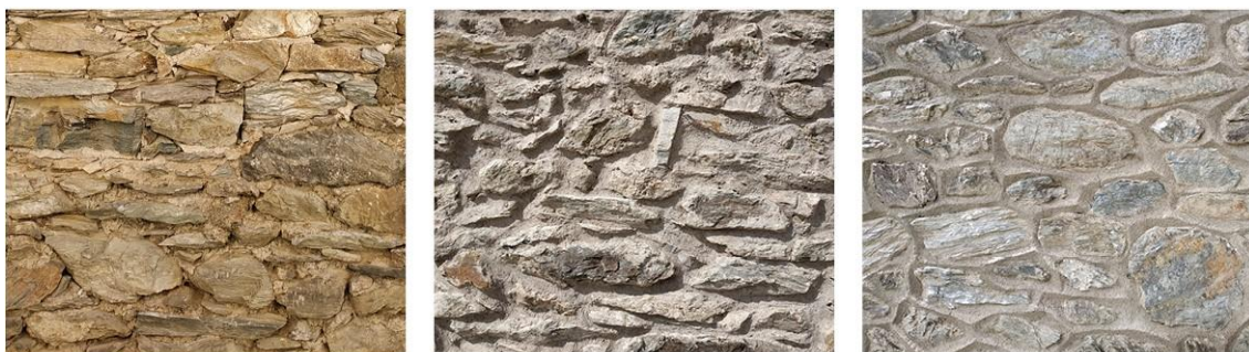
Fig. 33 Façanes de pedra vista amb morter de ciment
