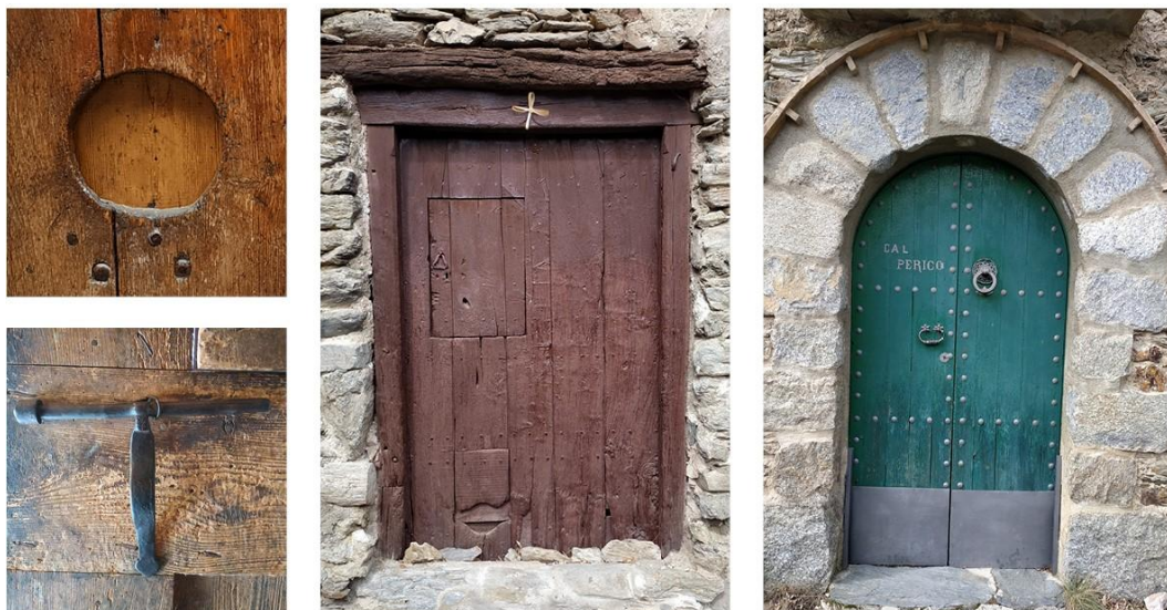
Fig. 25 Gatera, forrellat i portes
