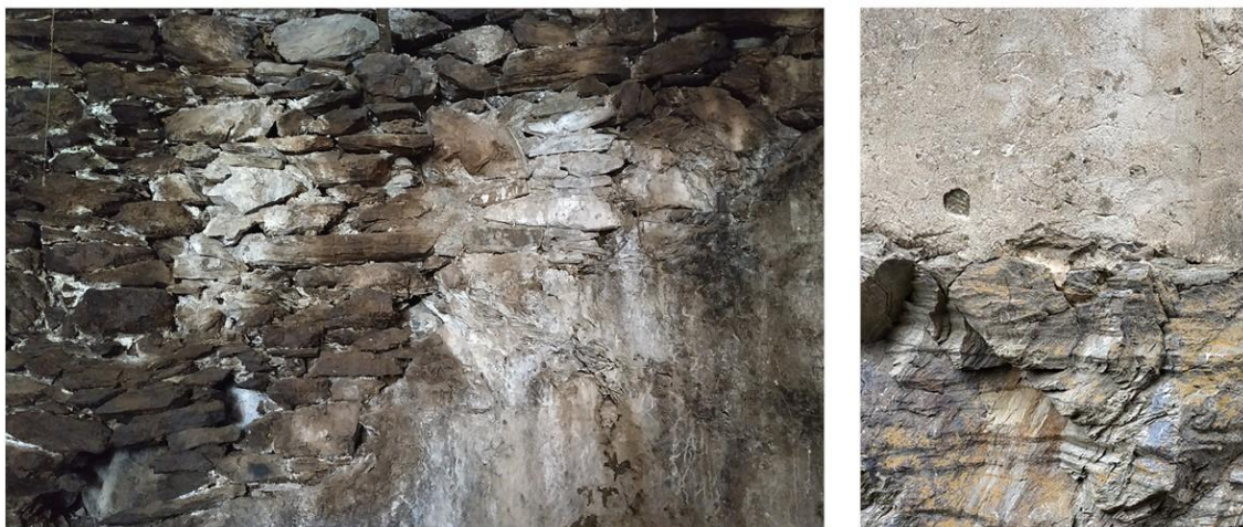
Fig. 19 Assentament sobre la roca
