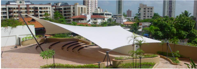
Figure 2: The membrane roof of the “Memorial dos Povos de Belém do Pará”
