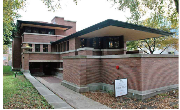
Figura 8. Detalle voladizos de cubierta de la Casa Robie, 1909.
