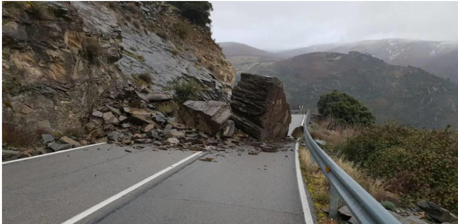
Figura 1: desprendiment rocós sobre una carretera després d'unes gelades a Benuza (Lleó). Font: Cadena Ser
