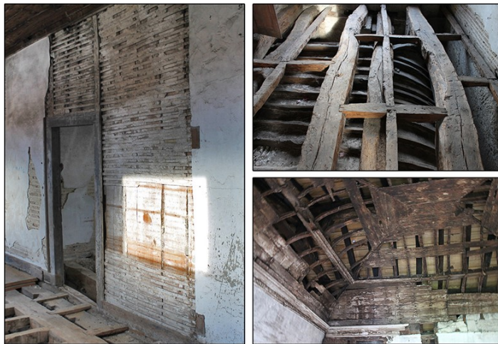
Fig. 7. Details of the wood used in the structures of the dormitory of the south cloister. Fig. 7. Detalhes da madeira utilizada nas estruturas do dormitório do claustro sul.
