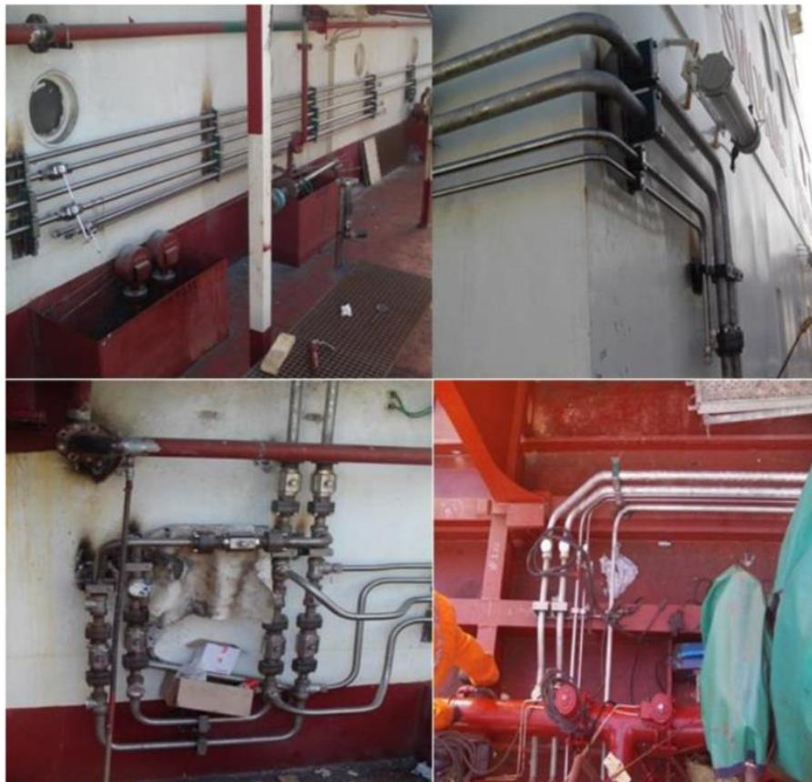
Imagen 36: Colocación de líneas para el sistema FRAMO. B/T Mencey 2016
