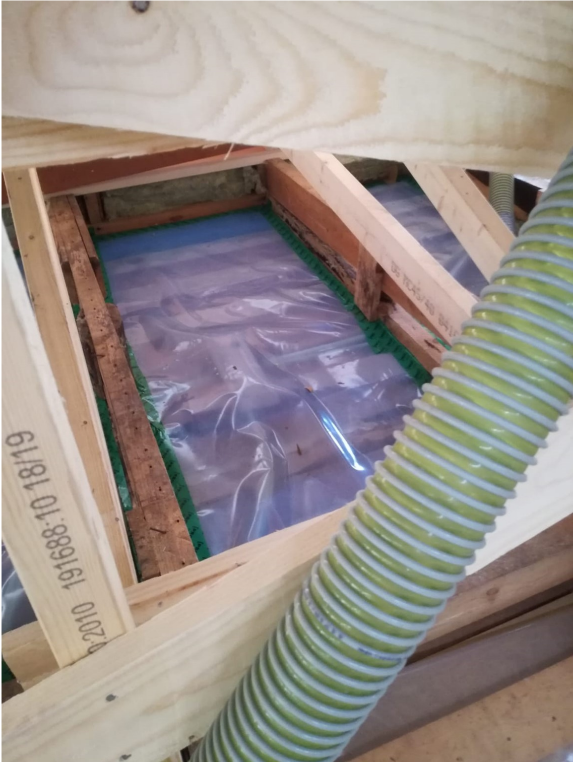
KUVA 5. Höyrynsulun korjaus. Samassa kuvassa näkyy uusien kattoristikoiden nurjahdustuentoja.
