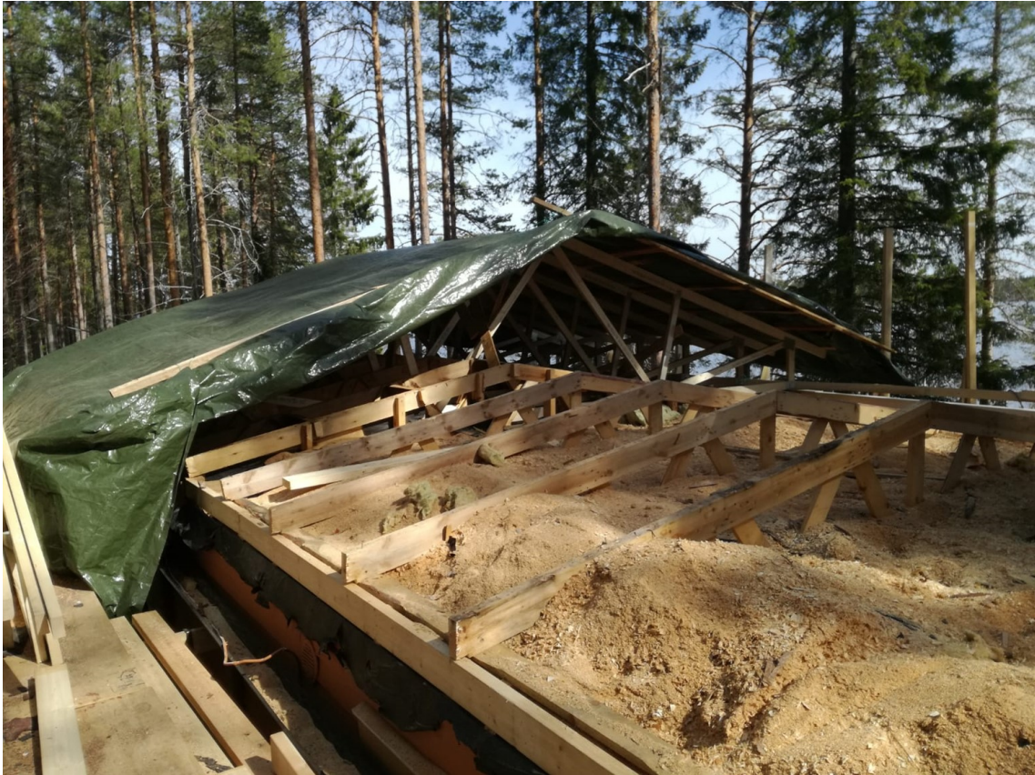
KUVA 4. Vanhat kattoristikot katkaistiin rakennuksen sivuseinien rungon tasaan, yläohjauspuuta vahvistettiin ja osin vaihdettiin. Ristikoiden asennustyö meneillään, väliaikainen suojaus asennettuna.
